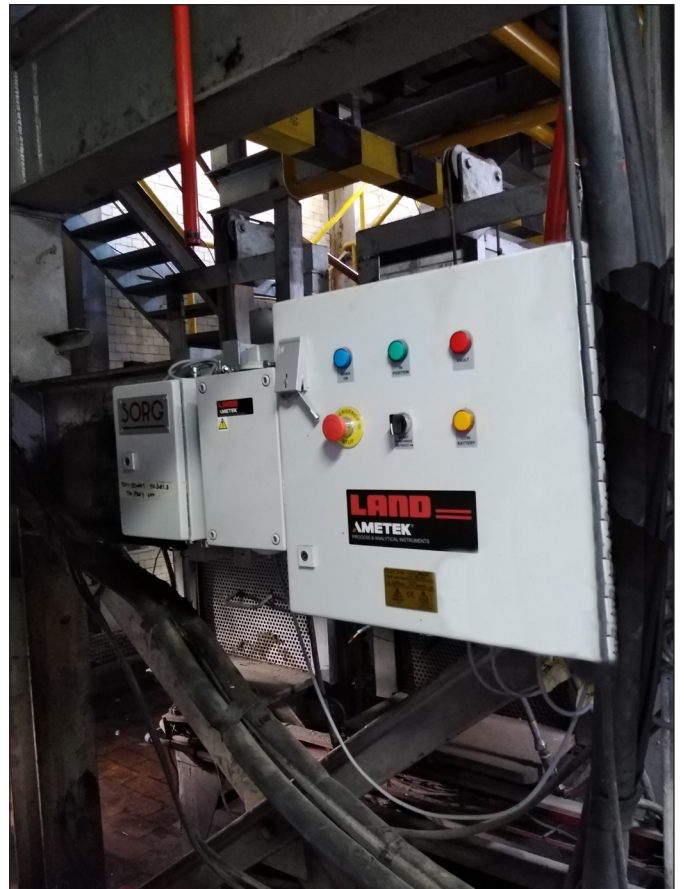
NIR-B-656-Glass 系统的安装示例
